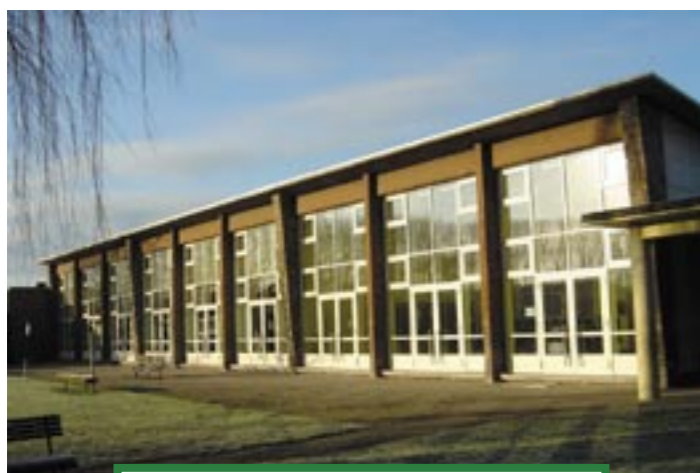
De vernieuwde ramen in de basisschool De Tovertuin te Willebroek
